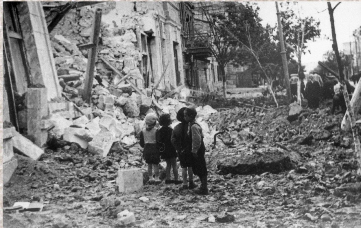
Севастопольские дети у разрушенного дома. 1941 - 1942 гг.
